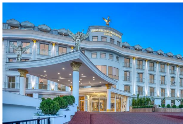
Внешний вид здания после реновации:
